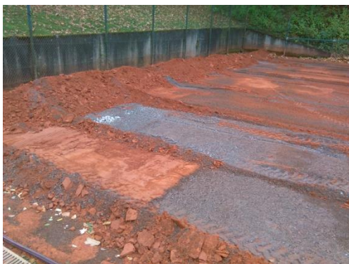
Entfernen der alten Lavaschicht
