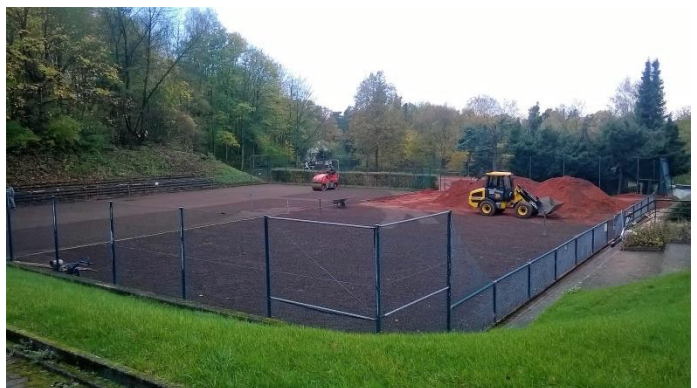
Auftragen der neuen Lavaschicht
