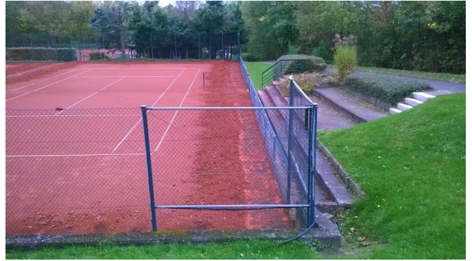
Ausbau der Ziegelmehldecke an den Rändern mit der Hand
