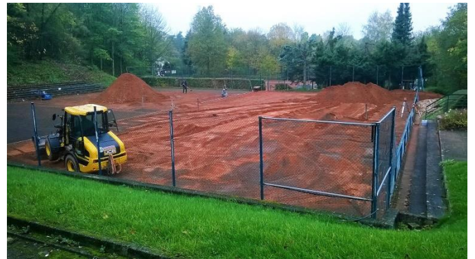
Maschinelles Entfernen der Ziegelmehlschicht
