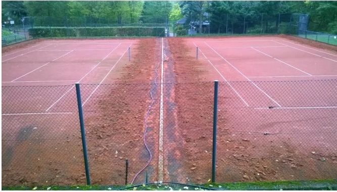
Ausbau der Ziegelmehldecke an den Rändern mit der Hand
