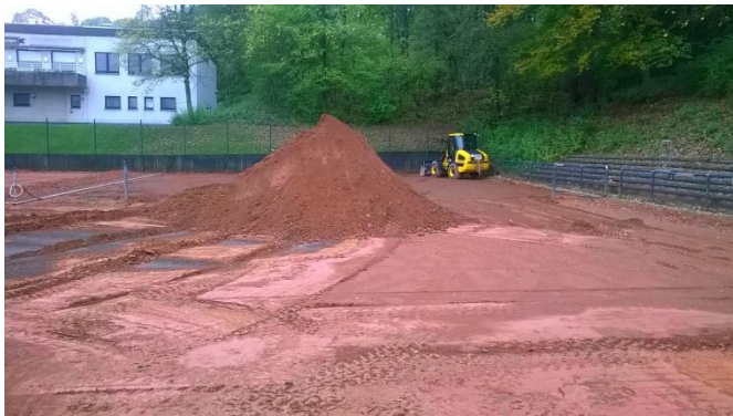
Maschinelles Entfernen der Ziegelmehlschicht
